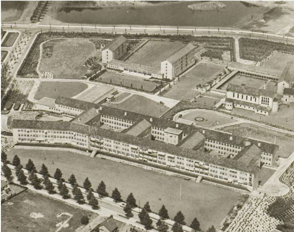
St. Lambertusziekenhuis gezien vanaf de President Rooseveltlaan (onder). Boven op de afbeelding de Hertog Jan van Brabantlaan met de vijver en de Warande. (fotograaf onbekend, collectie RHCe)
